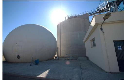
La digestión anaerobia es una fermentación microbiana en ausencia de oxígeno que da lugar a biogás (formado principalmente por metano o dióxido de carbono) y un material estabilizado conocido como fango digerido.
